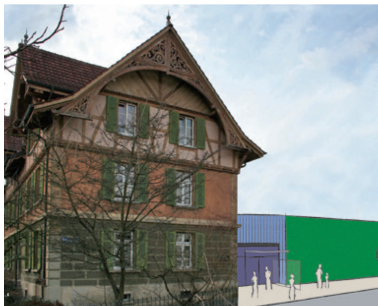
Le bâtiment de l'EJCM est charmant, mais vétuste et peu fonctionnel. Il sera donc rénové et agrandi d'un espace d'accueil et d'une grande salle de musique.
